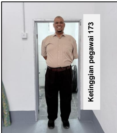
Tamu Desa Kg. Kudar, Kota Marudu - Bingkai Pintu Tandas Terlalu Rendah (04.11.2025) (Sumber : UAD KUSKOP)
