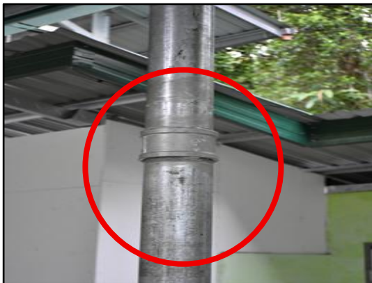
Tamu Desa Tradisi Melangkap, Kota Belud - Besi Yang Disambung Dijadikan Tiang Dewan (06.11.2025) (Sumber : UAD KUSKOP)
