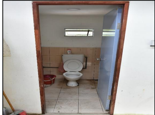
Tamu Desa Kg. Togudon, Penampang - Tandas Duduk Yang Dipasang (06.11.2025) (Sumber : UAD KUSKOP)
