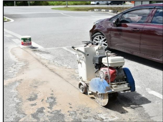
Tamu Desa Bahagia Teku, Sibuloh - Kerja-kerja sambungan bekalan air sedang dijalankan (11.11.2025) (Sumber : UAD KUSKOP)
