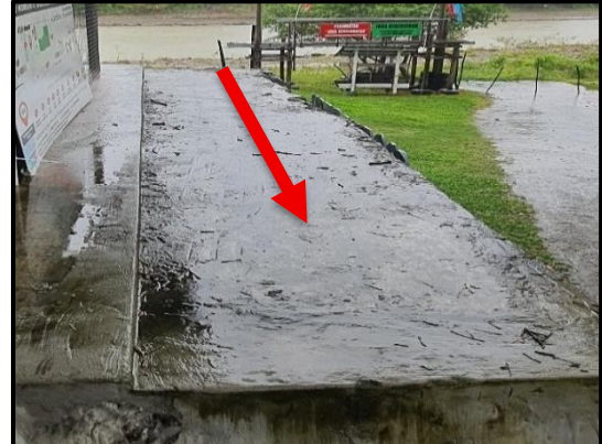
Tamu Desa Kg. Sosondoton Piasau, Kota Belud - Kerja menyimen permukaan gabion (05.11.2025) (Sumber : UAD KUSKOP)
