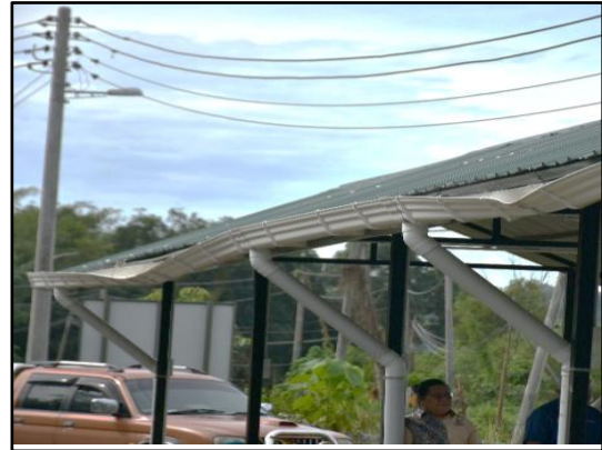
Tamu Desa Kg. Mahandoi, Penampang - Pemasangan Talang Cukur Atap Tidak Kemas (06.11.2025) (Sumber : UAD KUSKOP)
